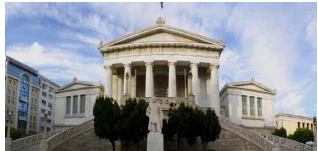
Πυροπροστασία Εθνικής Βιβλιοθήκης
