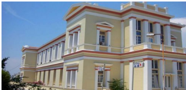
Πυροπροστασία Νοσοκομείου Ελπίς
