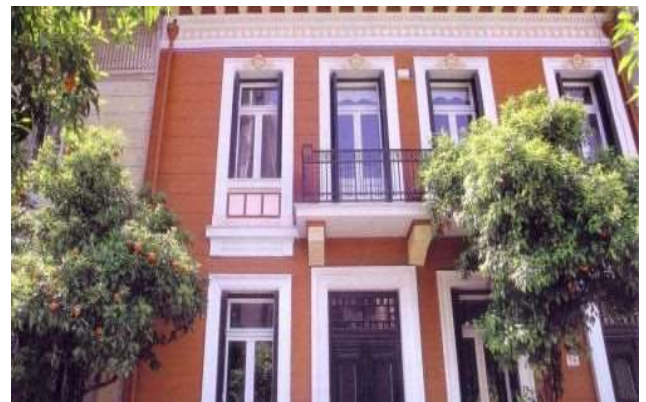
Διώροφη κατοικία στη Κυψέλη
