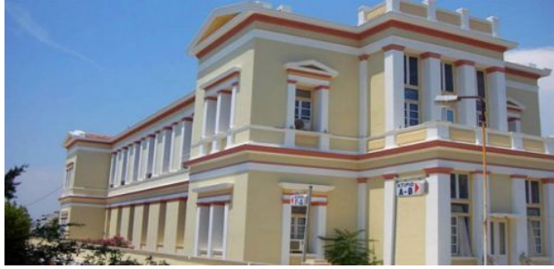
Πυροπροστασία Νοσοκομείου Ελπίς
