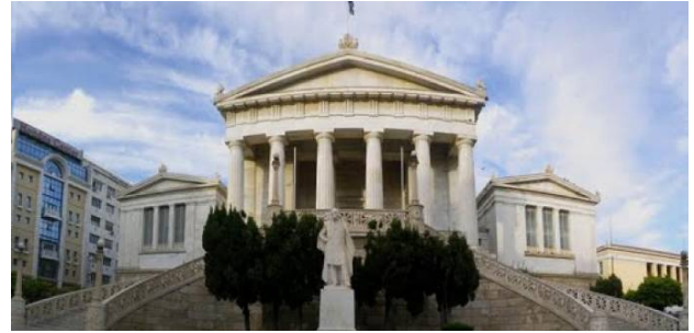
Πυροπροστασία Εθνικής Βιβλιοθήκης
